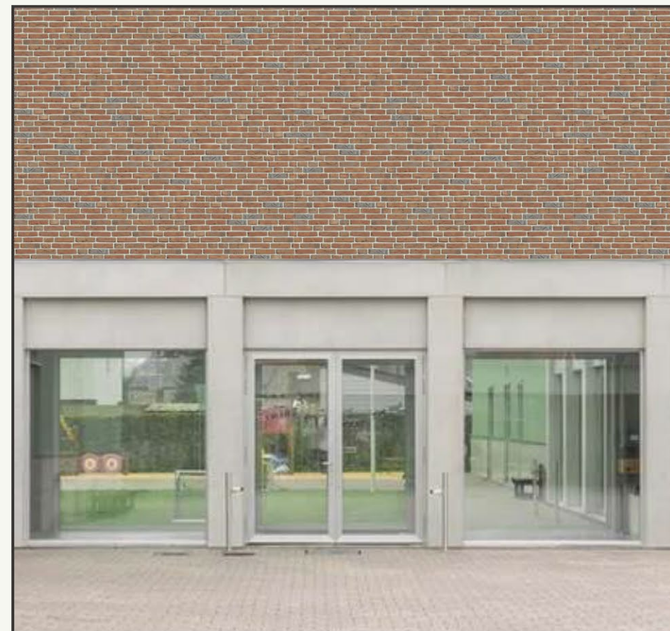
Omkadering van beton bij entree
